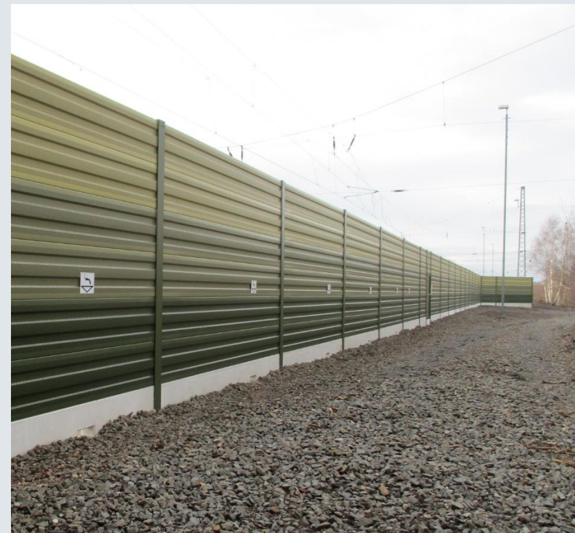
Projekt 6: Lärmschutzwand Höhe 3000 mm
