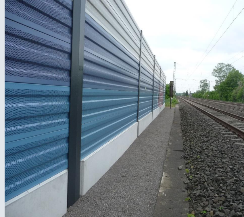
Projekt 9: Lärmschutzwand Höhe 3000 mm
