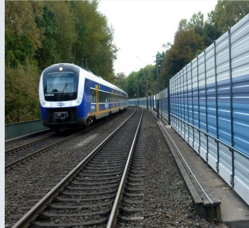
Projekt 10: Lärmschutzwand Höhe 3000 mm
