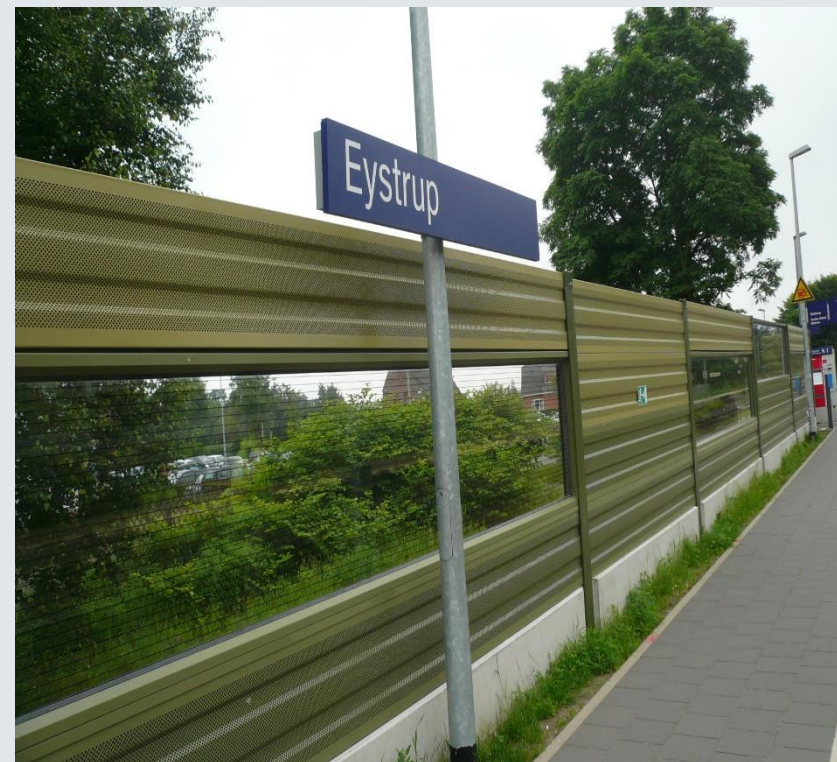
Projekt 13: Lärmschutzwand Höhe 2000 mm
