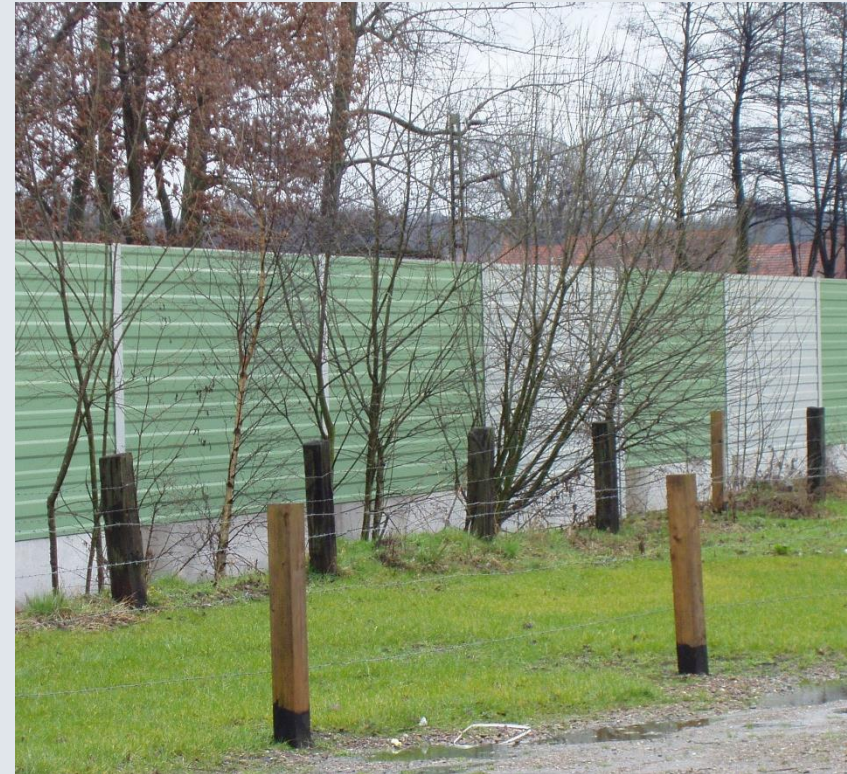
Projekt 3: Lärmschutzwand Höhe 3000 mm
