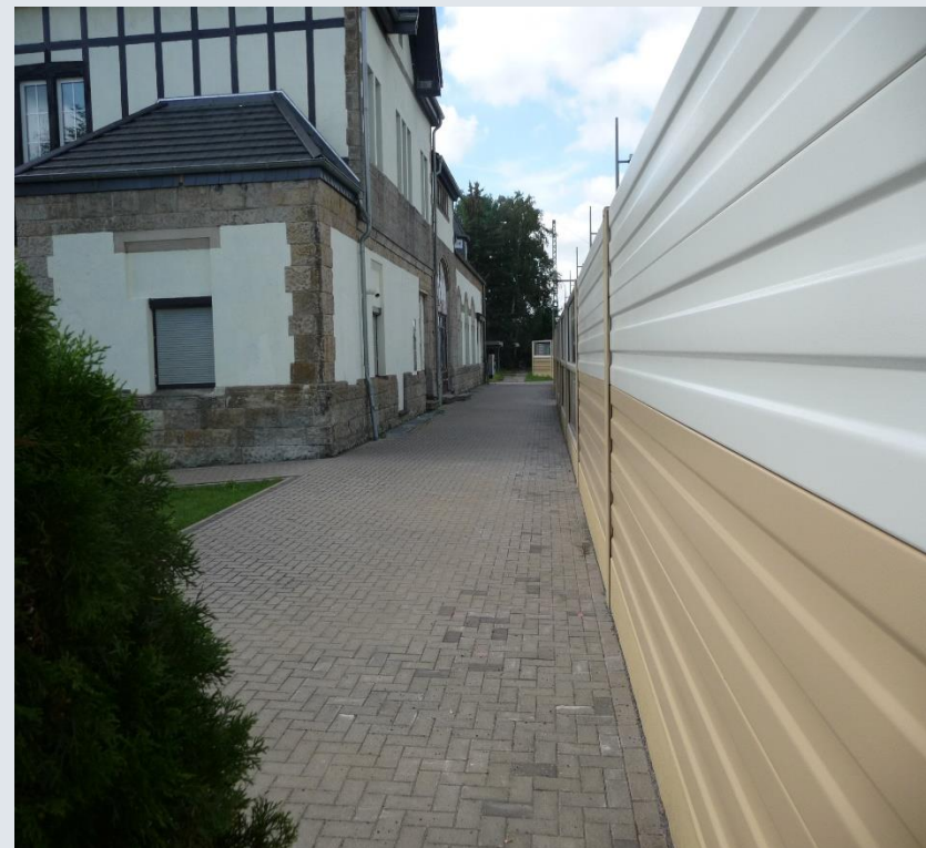
Projekt 12: Lärmschutzwand Höhe 2000 mm
