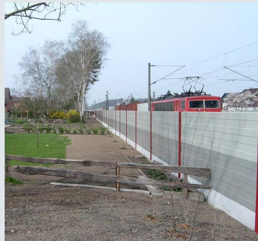
Projekt 1: Lärmschutzwand Höhe 2000 mm
