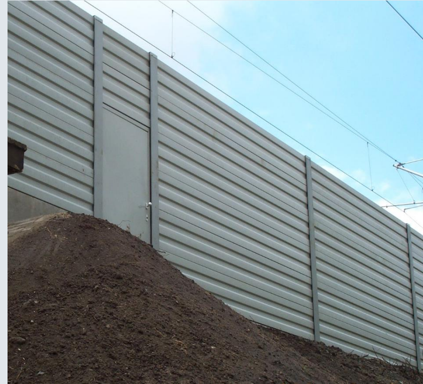
Projekt 2: Lärmschutzwand Höhe 3000 mm
