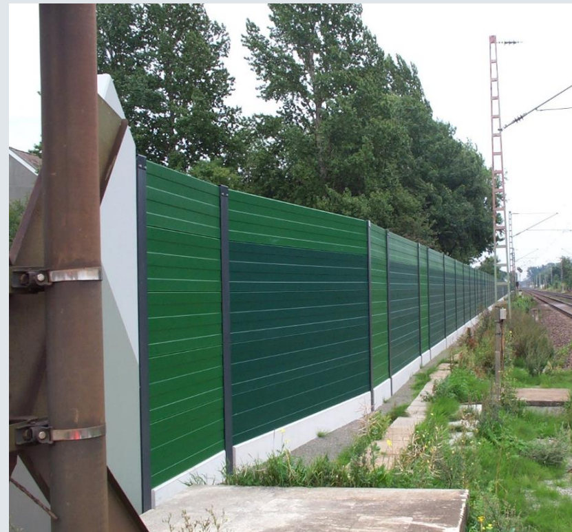
Projekt 7: Lärmschutzwand Höhe 2500 mm
