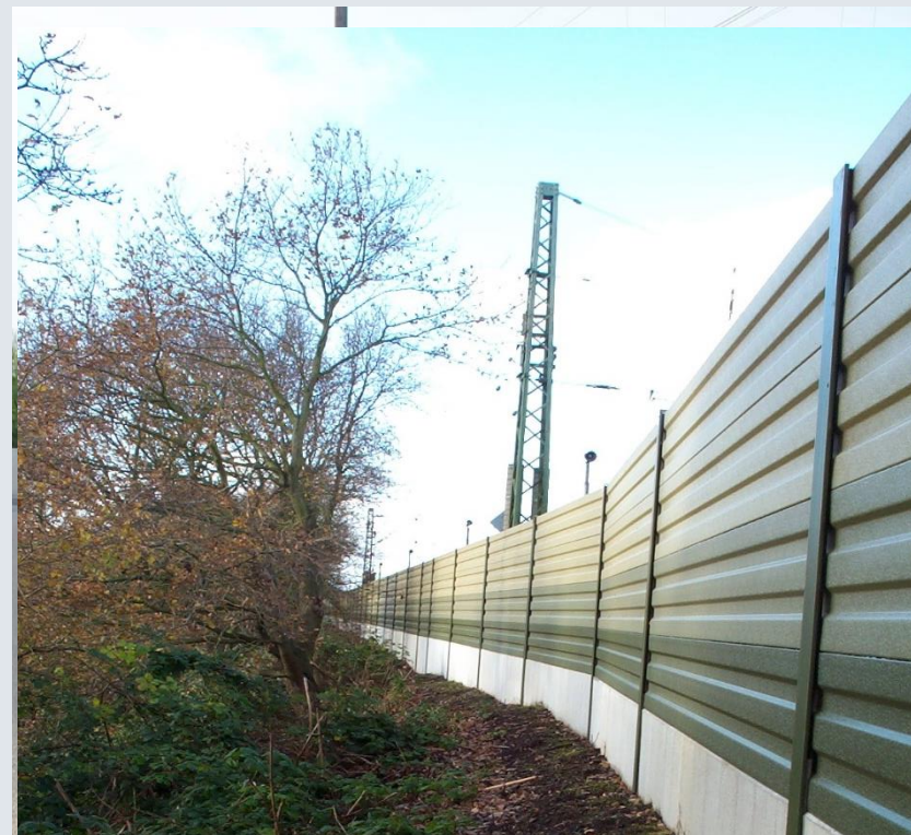
Projekt 4: Lärmschutzwand Höhe 2000 mm
