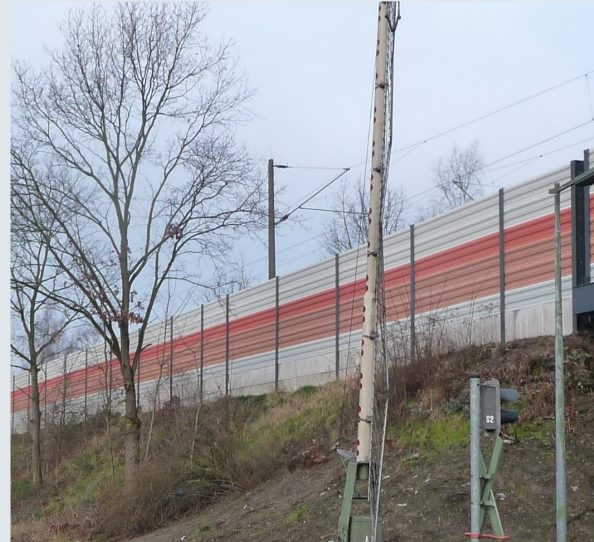
Projekt 11: Lärmschutzwand Höhe 3000 mm
