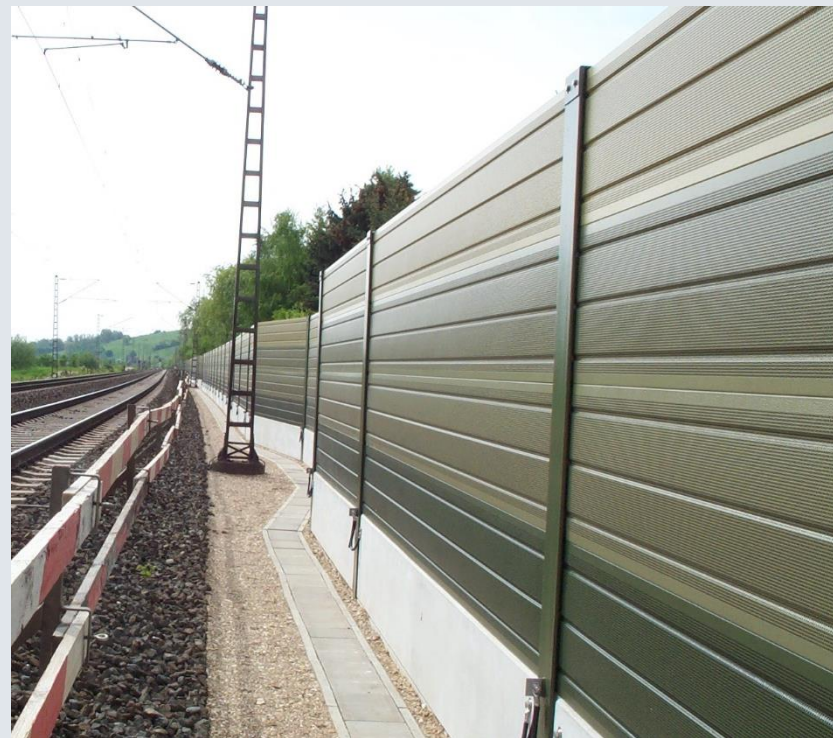
Projekt 5: Lärmschutzwand Höhe 2000 mm
