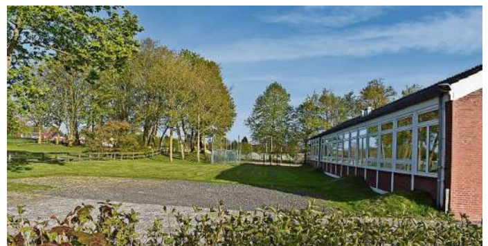
Neben dem Schulgebäude in Seefeld soll ein Anbau in modularer Bauweise entstehen. Dabei werden auch Flächen des angrenzenden Spielplatzes in Anspruch genommen. Foto: Lohe
