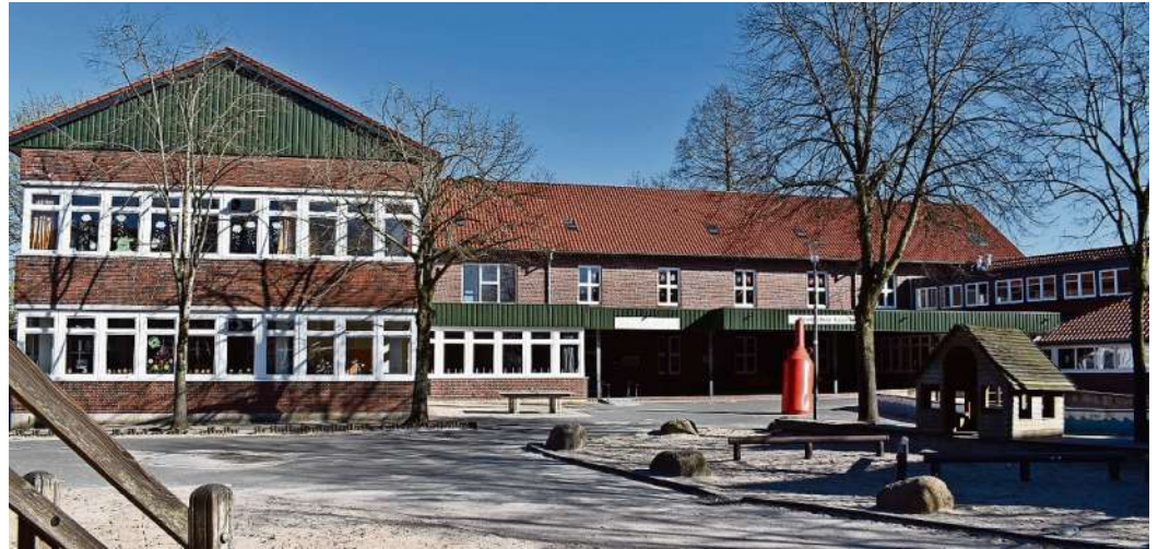
Die Grundschule in Rodenkirchen soll durch Anbauten auf Kosten der Gemeinde für den Ganztagsbetrieb räumlich erweitert werden. Foto: Lohe
